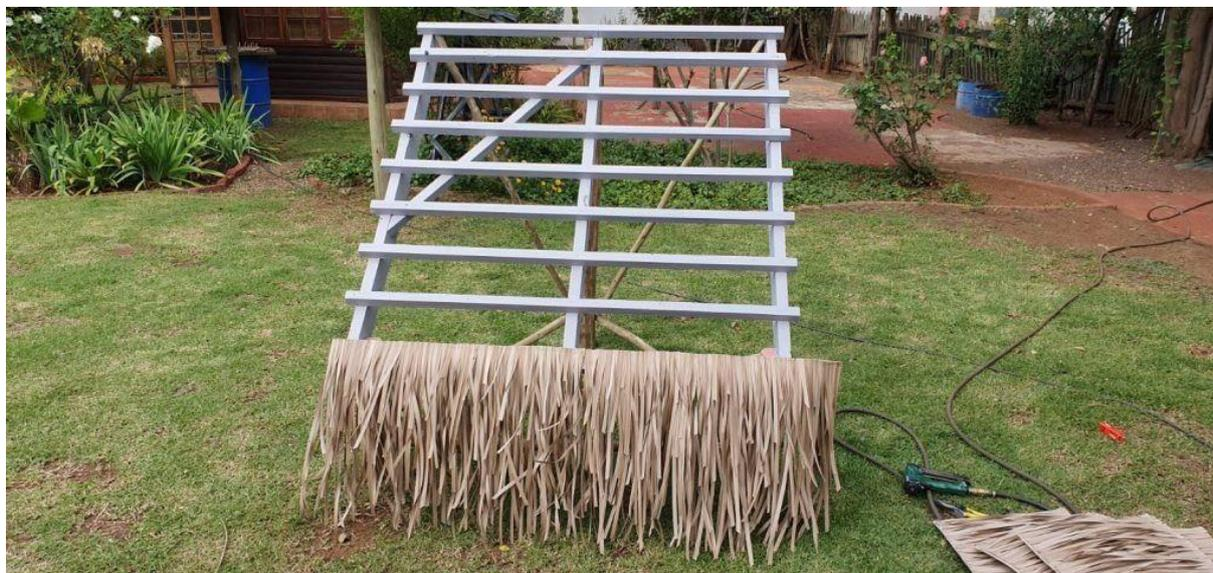
**2<sup>ème</sup> étape** : Pose des tuiles avec un espacement de 45 cm entre chaque rangée, de façon à recouvrir la bande cousue de chaque tuile.
