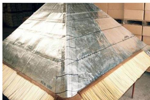
Les lignes horizontales se rejoignent dans les angles. Tracer 2 points à 100 mm de chaque côté des angles sur les lignes horizontales. Tracer une ligne courbe qui joint ces 2 points et qui se situe à 75 mm au dessus du croisement des lignes horizontales aux angles. Cela permet d'adoucir les angles. Tracer la même ligne courbe à mi-chemin de 2 lignes horizontales pour fixer les demi-tuiles, pour combler les vides éventuels créés par le pliage des tuiles dans les angles.
